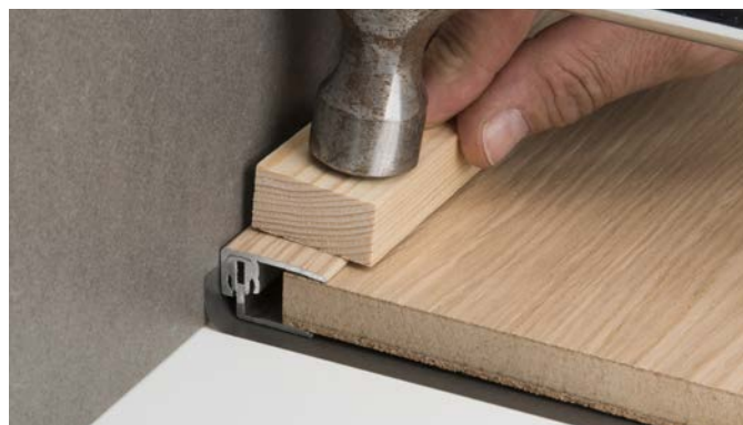
Instalace ukončovacího profilu hliníkového
